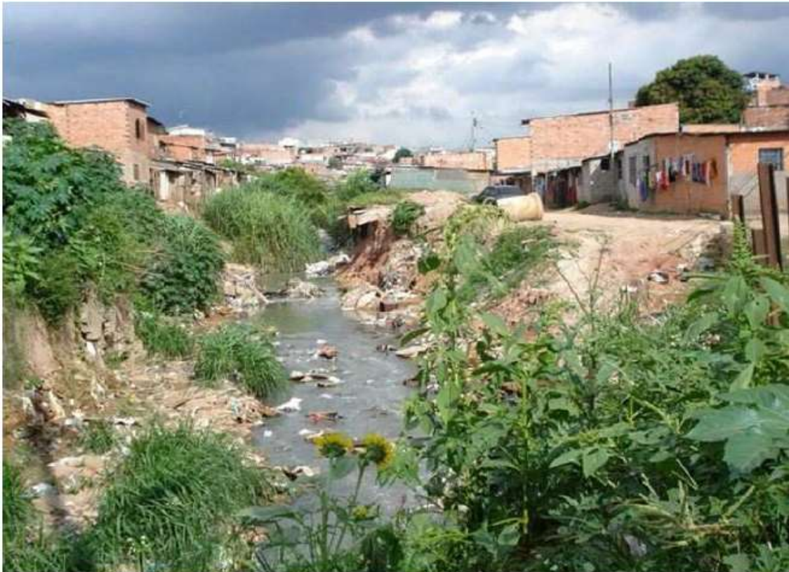
Figura 1.2 - Casas construídas em área de risco, ao lado de um esgoto a céu aberto. Fonte: http://www.dgabc.com.br
