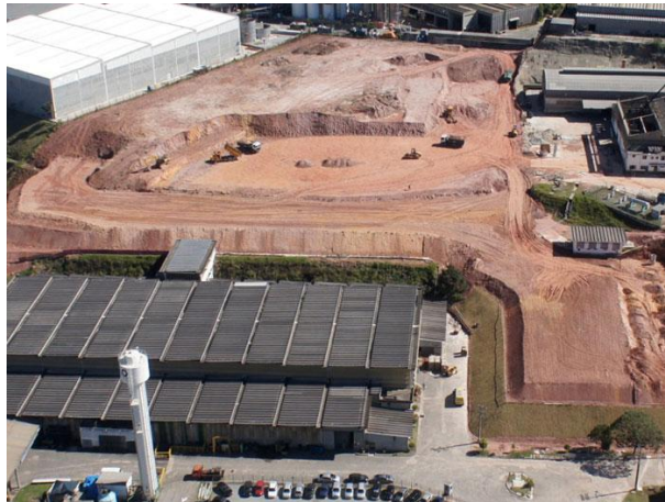
Foto 2: Obra da construção do heliporto em Osasco. Fonte: Helicentro Brasil – HBB.
