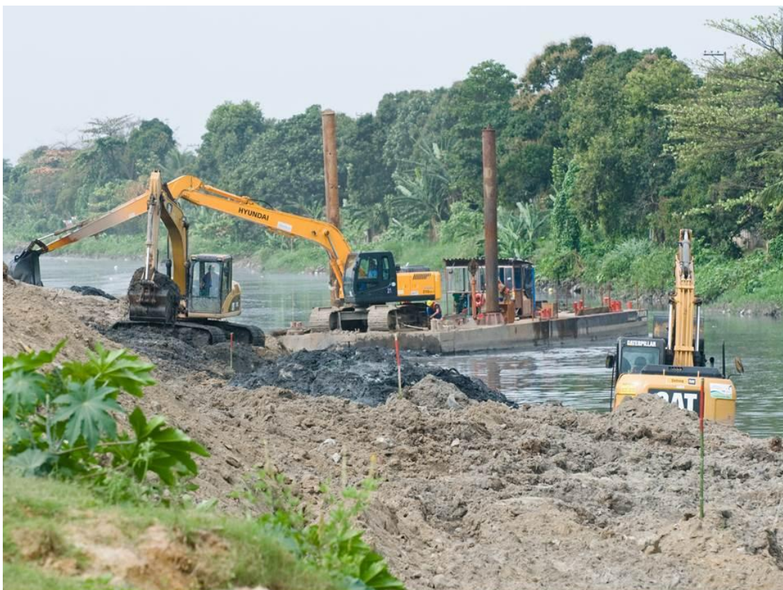
Fig.2 – Rio Sarapuí. Imagem dos equipamentos sobre balsas.
